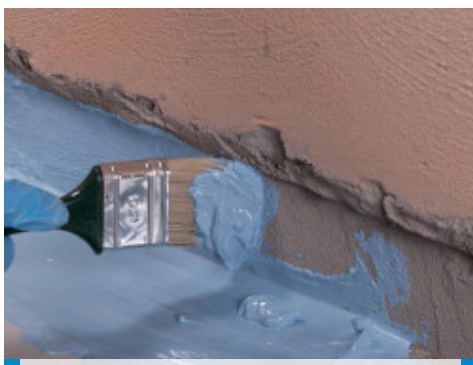
A Mapelastic AquaDefense Zero felhordása ecsettel a fal-padló csatlakozáshoz a Mapeband Easy elhelyezése előtt
