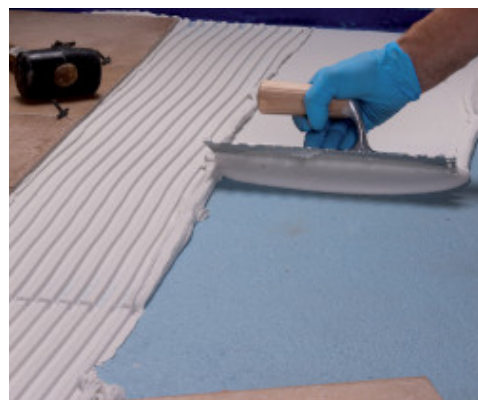
Burkolólapok ragasztása a Mapelastic AquaDefense Zero-ra
