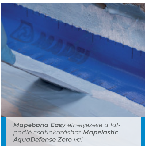
Az első réteg Mapelastick AquaDefense Zero felhordása esztrichre
