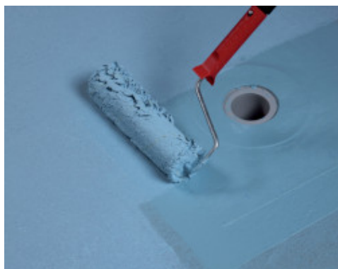
A Mapelastic AquaDefense Zero második rétegének felhordása hengerrel
